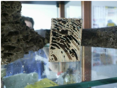
Dégâts dans le bois
