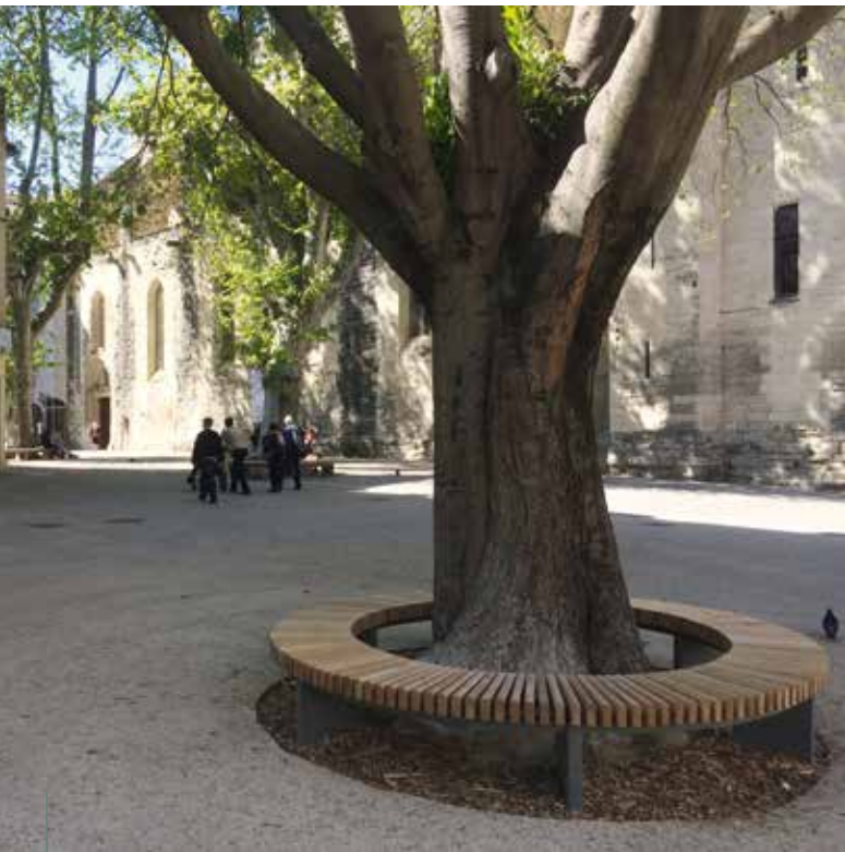
Des banquettes circulaires, surmontées de lames en bois posées sur la tranche, ceinturent les platanes de la place Saint-Didier. Les paysagistes ont opté pour du robinier brut, sans traitement, ni lasure, ce qui réduit l'entretien.
