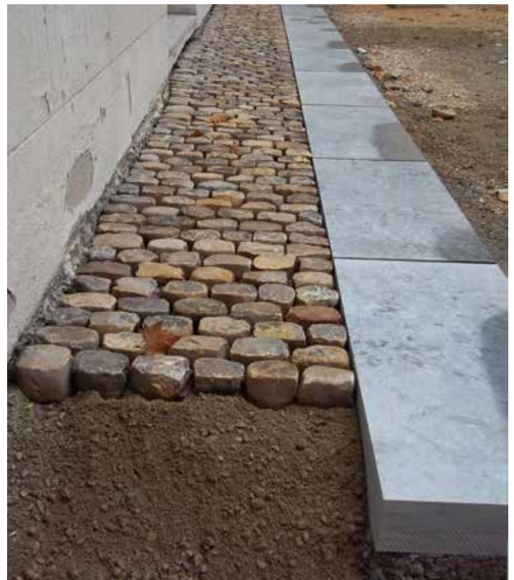
En pied de façades, des calades, conçues à partir de galets en fourniture et récupérés sur site, et des dalles en pierre de Baronnie de 40 cm de large, soulignent le bâti et renforcent le caractère historique des lieux.
