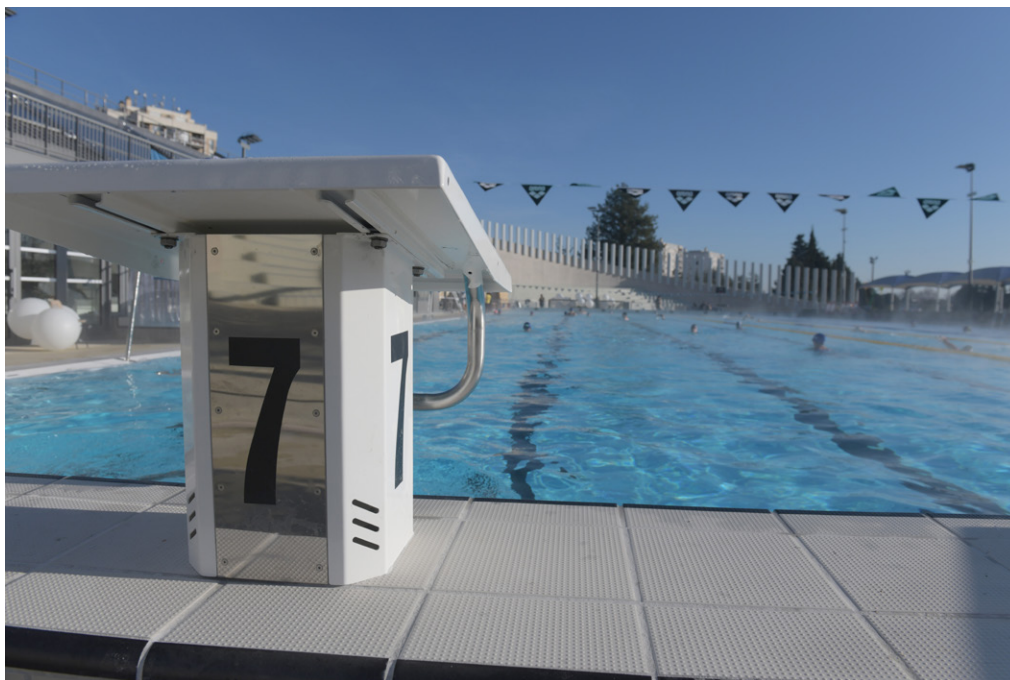
Bassin de 50m
