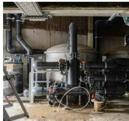
À sous-sol, le cœur de la piscine : le système de filtration en continu des bassins, composé de quatre cuves avec filtres à diatomé engendrant une économie d'eau. Une grue sur mesure a été construite pour accéder aux filtres lors des lavages.
