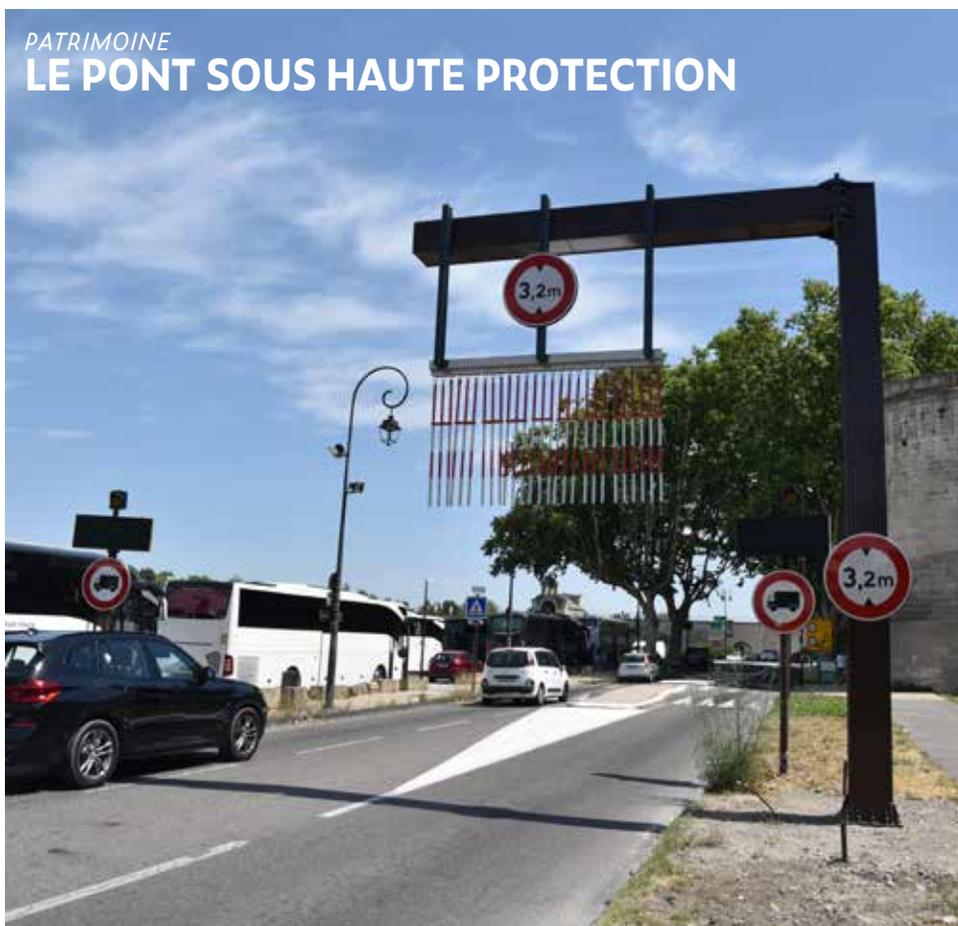
La Ville a installé le 16 juin dernier deux potences de protection en amont du Pont Saint-Bénézet afin de le protéger des chocs des véhicules de plus de 3,20 m de hauteur.
