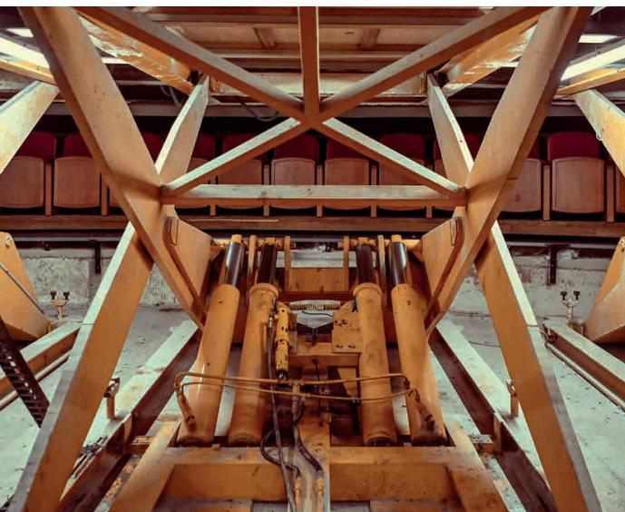
Une machinerie complexe se cache derrière la scène surélevée de l'Opéra. Dessous, quatre vérins hydrauliques permettent de descendre ou monter la fosse d'orchestre. On peut voir à l'avant-scène les nouveaux fauteuils, réduits à 950 pour le confort des spectateurs. ▲
