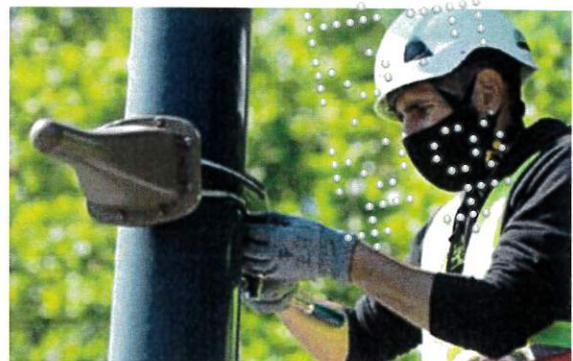
Installation de station de mesure de la qualité de l'air extérieur
