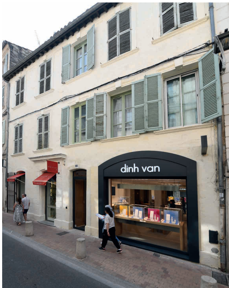
La façade du 14 rue Joseph Vernet a bénéficié d'une rénovation subventionnée par la Ville
