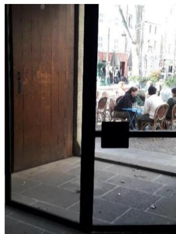
**Photos N° 5 et 6** : Porte secondaire sur le flanc de la salle de la chapelle st Michel (largeur de Passage de moins de 70 cm avec une marche intérieure sans rampe accès PMR)
