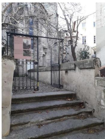
**Photo n°2** : Porte secondaire entrée salle des Cordeliers avec une marche, largeur de passage 96 cm (pas de rampe accès PMR).
