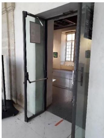
**Photo N° 3** : Portes doubles vitrées avec poignets anti paniques avec ouverture électrique au fond de la salle RDC donnant a accès a l'ascenseur Accès PMR
