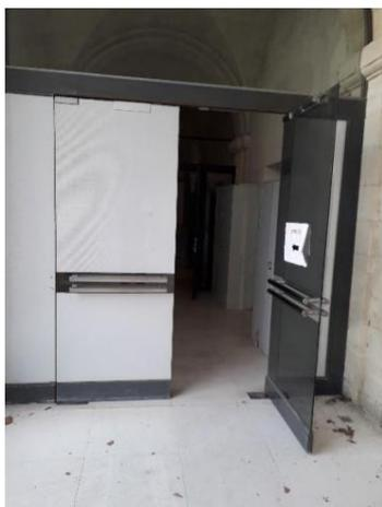
**Photos n°6 et 7** : La salle du RDC a un accès sans marches, avec de grandes ouvertures Photos N° 2 et 3, qui sont équipées de poignées anti paniques Accès PMR
