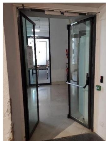
**Photo n° 4** : Portes doubles vitrées accès salle 1e étage et 2eme étage avec ouverture électrique sans poignets anti-paniques Accès PMR
