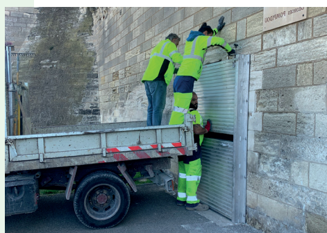
Montage des batardeaux par les agents municipaux pour protéger contre le risque inondation
