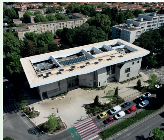
Panneaux solaires sur la toiture de la Bibliothèque Renaud-Barrault
