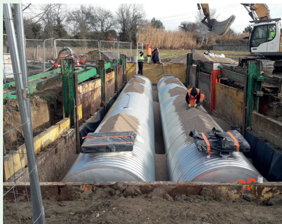
Cuve enterrée de récupération d'eau de pluie de la « forêt enchantée »
