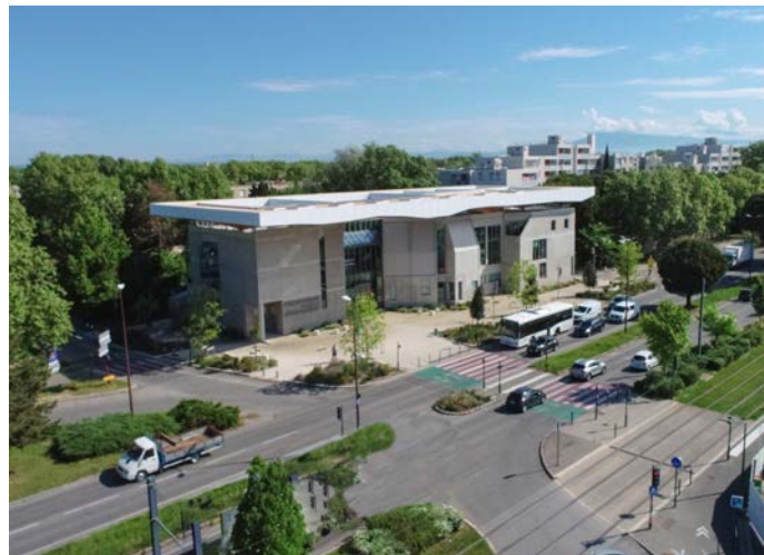
Rénovation de la Bibliothèque Renaud-Barrault et création de son parvis Coût 8,7 M€ (2,18 M€ en 2024)
