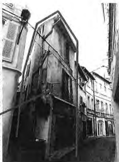
Façade avant l'incendie
