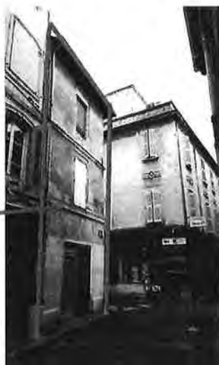
Façade rue Bonneterie
