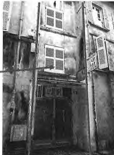
Façade rue Bonneterie
