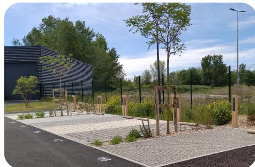
*Parking permettant de tester différents types de revêtements perméables.
