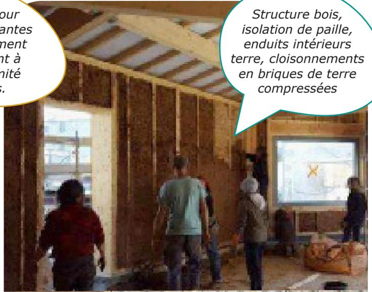
Structure bois, isolation de paille, enduits intérieurs terre, cloisonnements en briques de terre compressées
